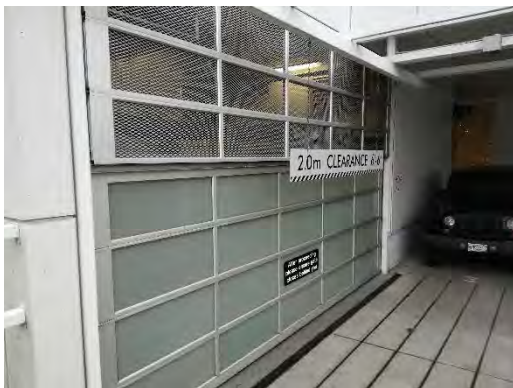
Item 24 - Overhead Garage Door
