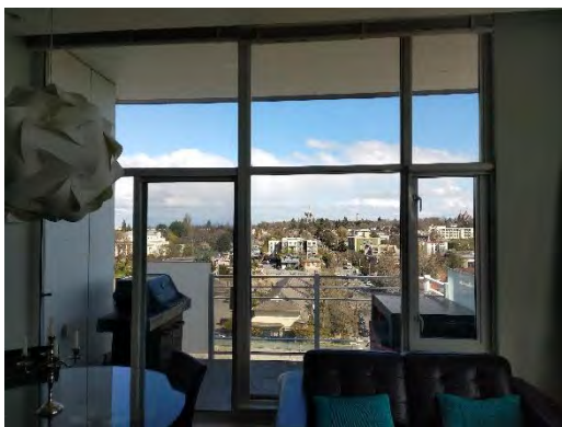
Item 21 - Balcony Swing Doors
