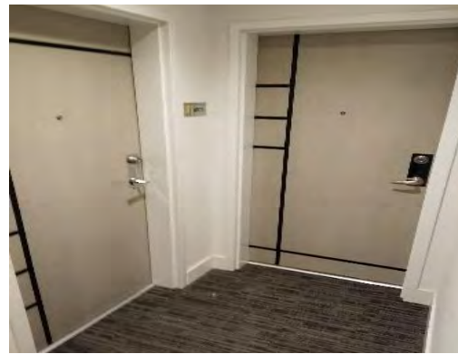
Item 32 - Suite Entry Doors
